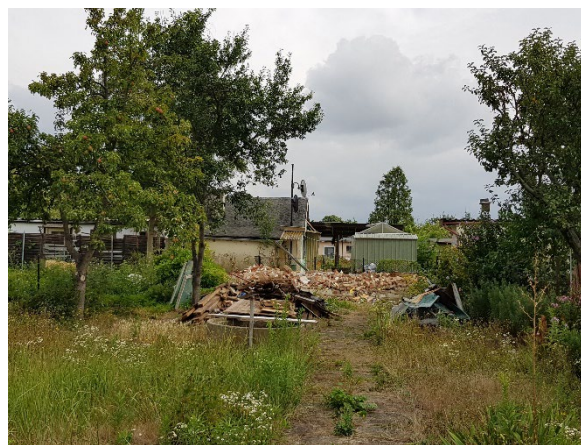
Abb. 31: Laube im Rückbau in der Anlage Nr. 54 „Reiter“ e.V.
