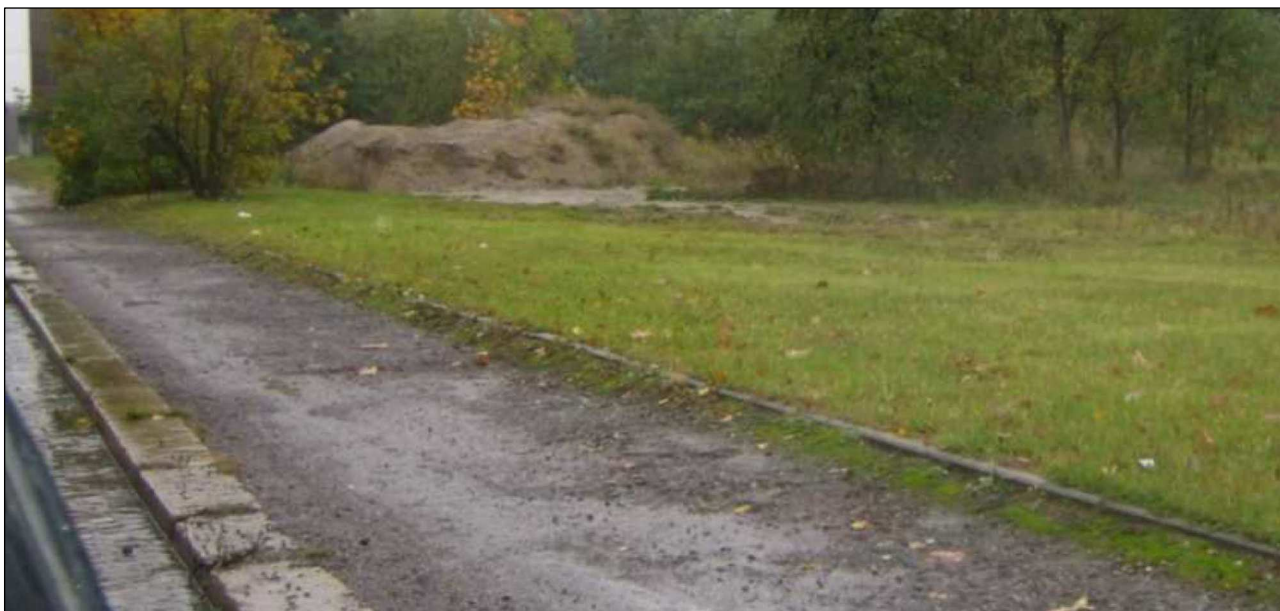
Abb. 2: Ungeeignete Deckschicht, ungenügende Breite
