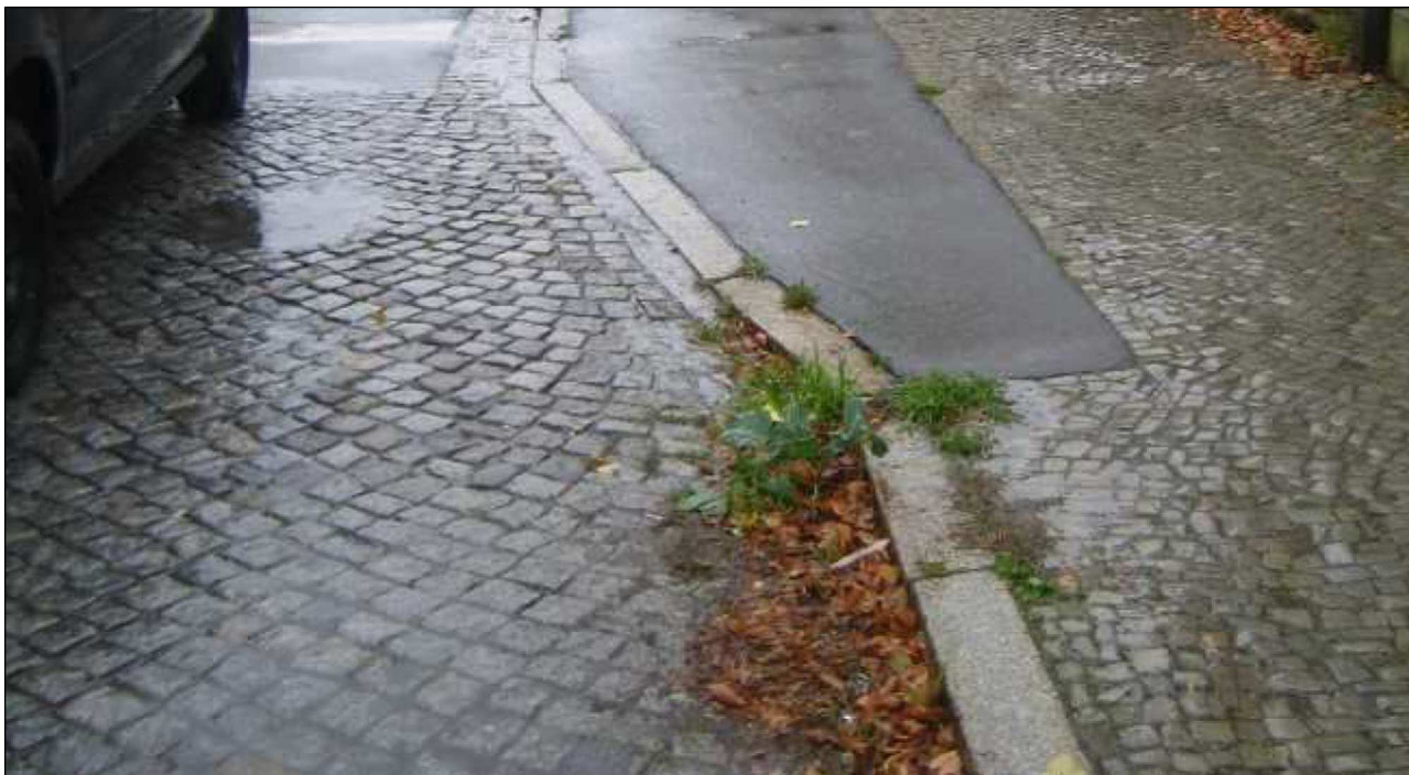
Abb. 3: Ungeeignete Deckschicht, ungeeigneter Radweganfang
