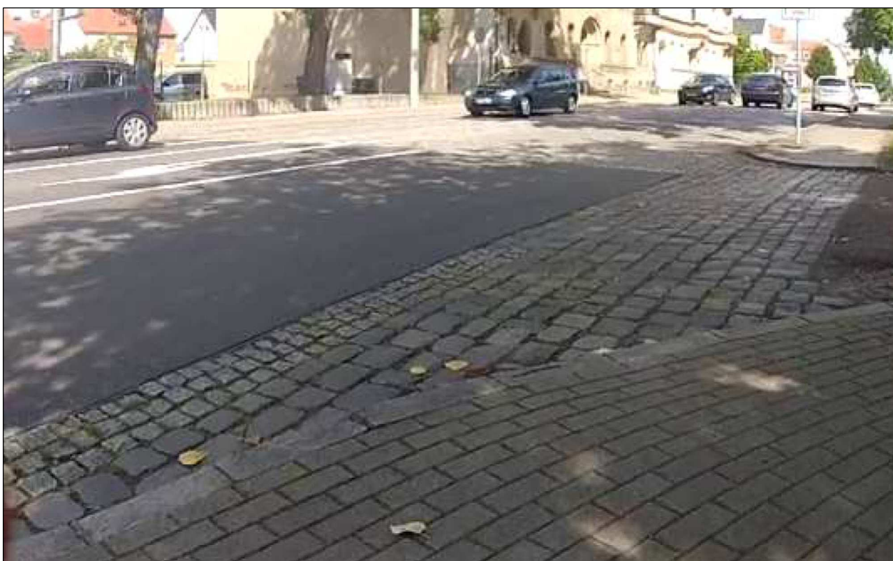
Abb. 4: Ungeeignete Deckschicht, ungeeignetes Radwegende
