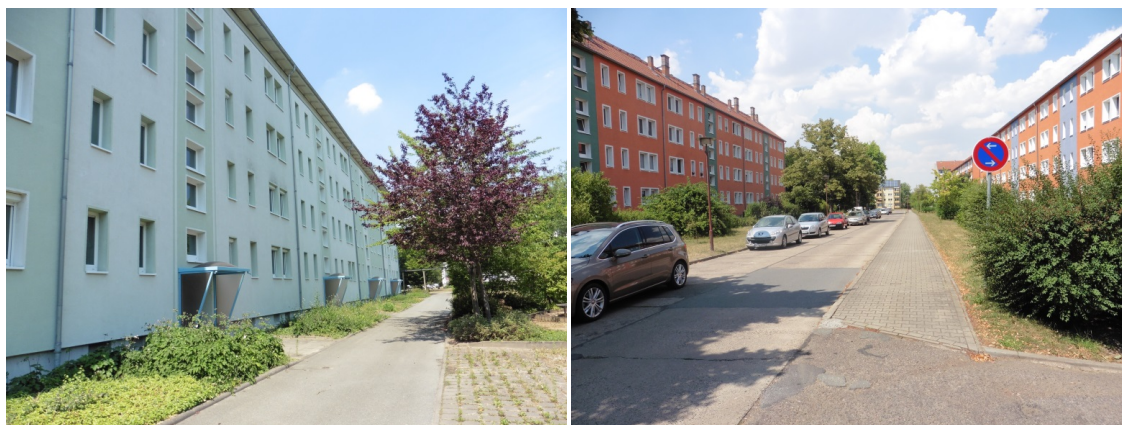
Abbildung 21 Plauener Straße 2 a-f (Rückbau in Durchführung) 19 ; Wismarer Straße 1-9 (geplanter Rückbau links) 20
