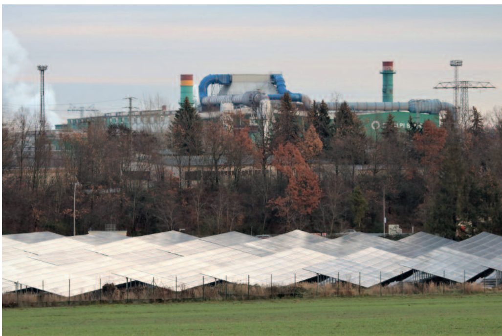
Energiekrise und Klimawandel verlangen nach Lösungen: Das neue Photovoltaik-Kraftwerk gehört dazu.
