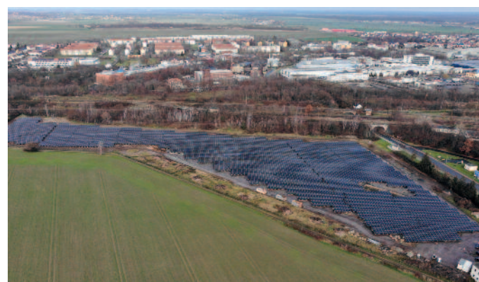
Die Anlage an der Rostocker Straße. © J. Bahmann (Inst. für Energie)
