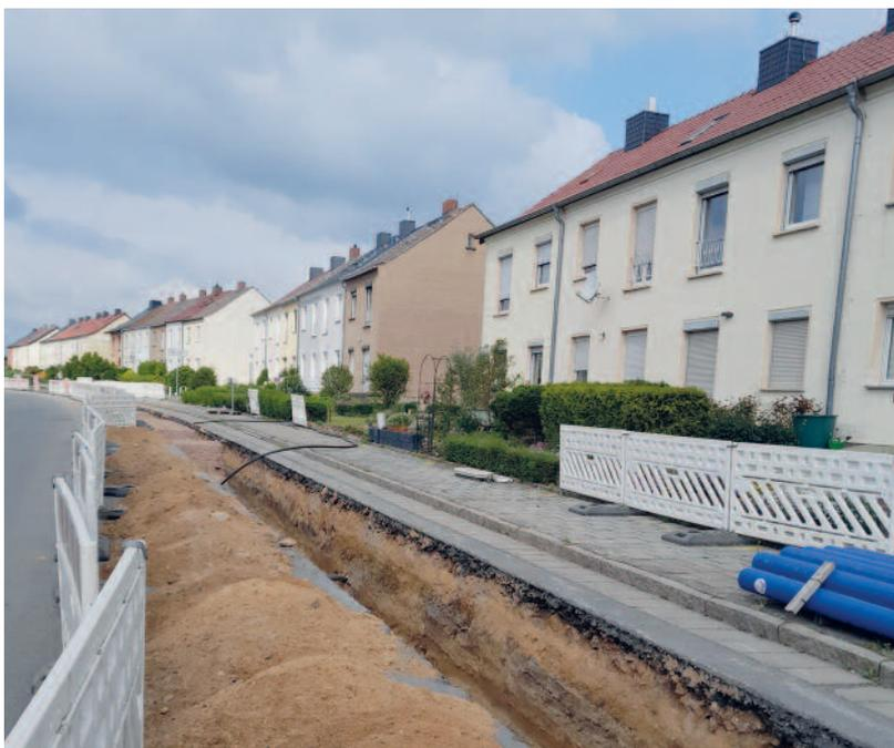
In der Alleestraße wurden alte Grauguss-Trinkwasserleitungen durch PE-Leitungen ersetzt.
