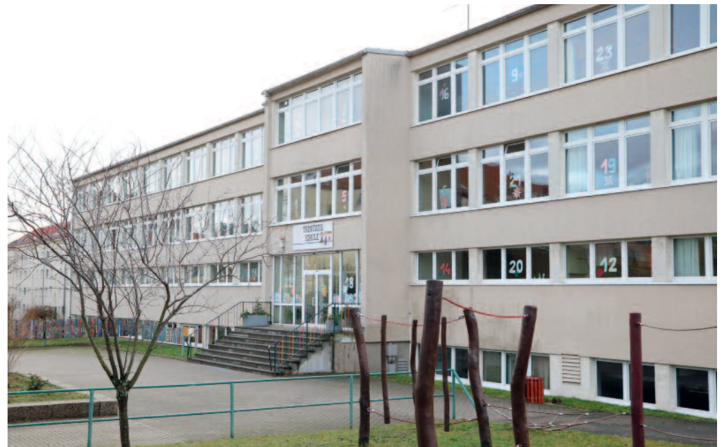
Die Trinitatisschule an der Schillerstraße soll umfassend saniert werden.
