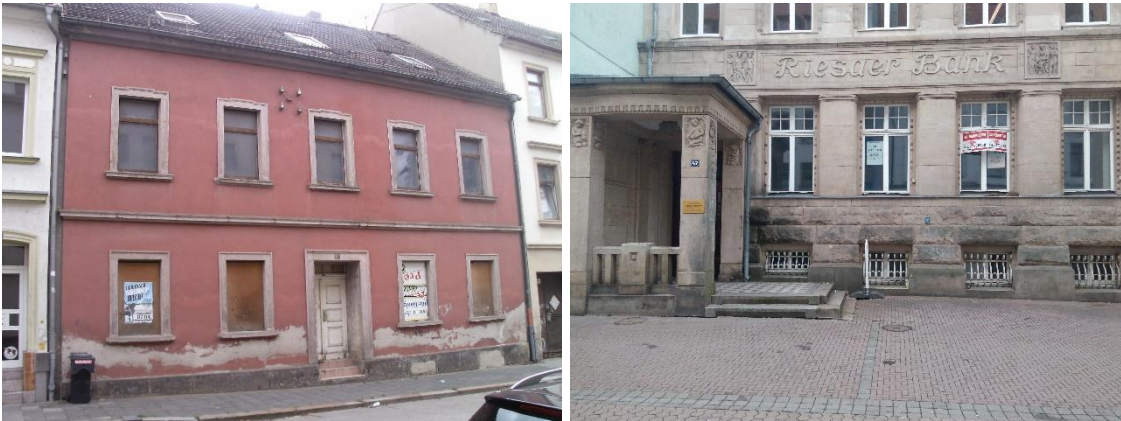
Abbildung 7 Gebäude mit schlechtem Sanierungsstand
