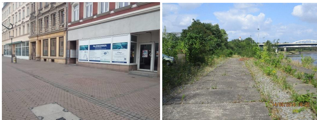
Abbildung 30 Weiterer Aufwertungsbedarf leerstehende Läden, Elbradweg
