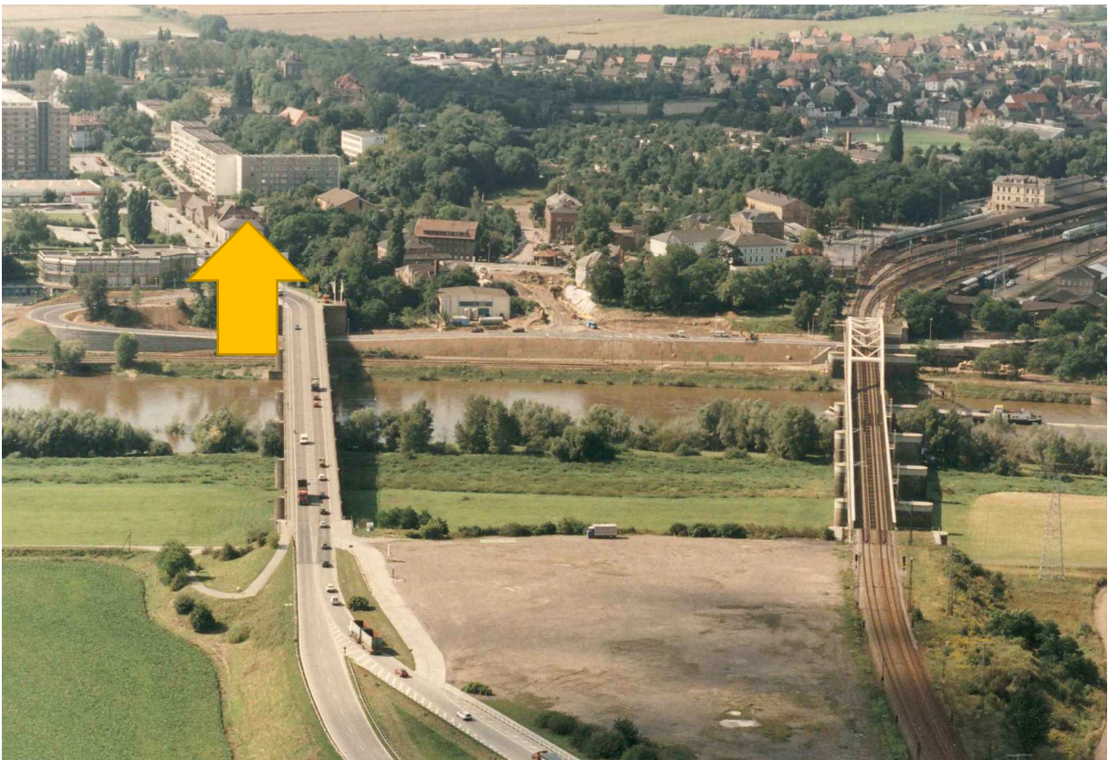
Wohngebäude Berliner Straße 1-11, 13-19 und 21-25 vor dem Etagenrückbau um das Jahr 2000
