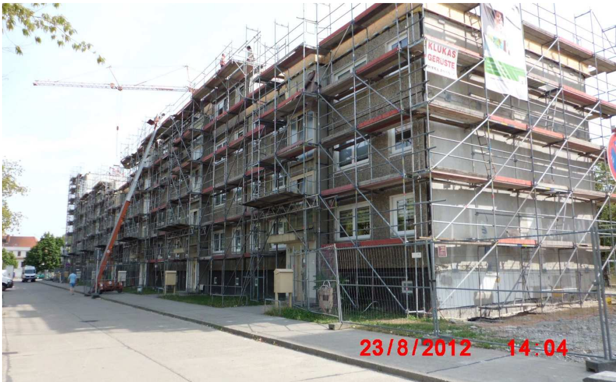
Wohngebäude R.-Breitscheid-Straße 3-19 vor und während des Rückbaus im Jahr 2012
