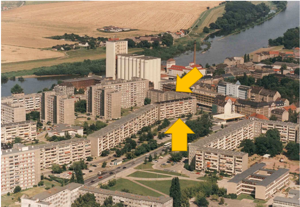
Wohngebäude Klötzer Straße 2-10 und Karl-Marx-Ring 2-8 vor dem Rückbau um das Jahr 2000
