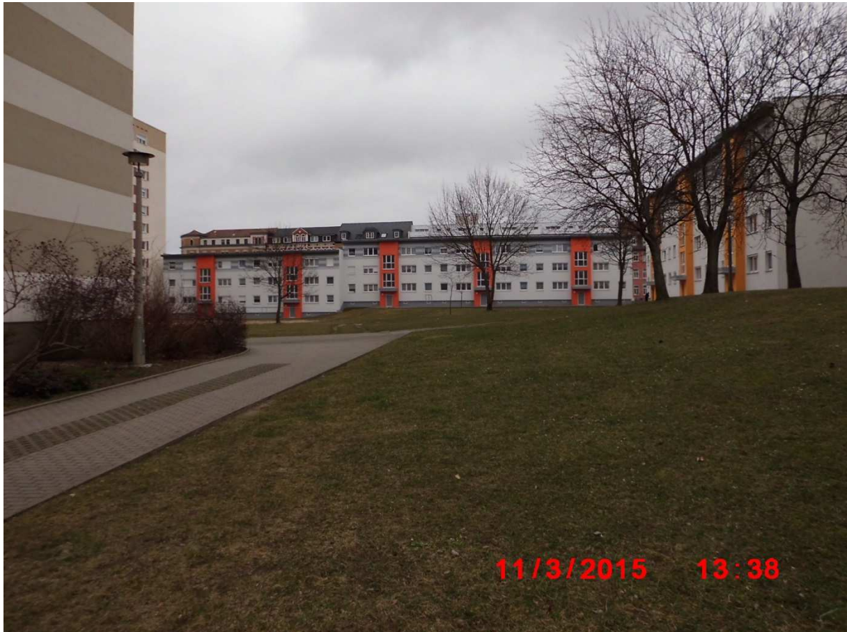
Wohngebäude Klötzer Straße 2-10 und Karl-Marx-Ring 4-8 nach dem Etagenrückbau im Jahr 2013+2014
