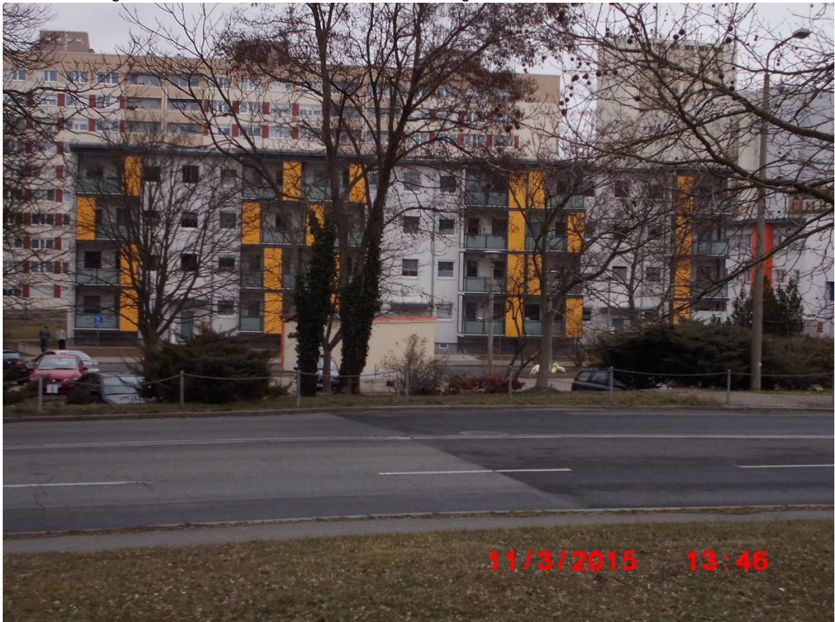
Wohngebäude Karl-Marx-Ring 4-8 nach dem Rückbau des Eingangs Nr. 2 im Jahr 2013 und dem Etagenrückbau im Jahr 2014
