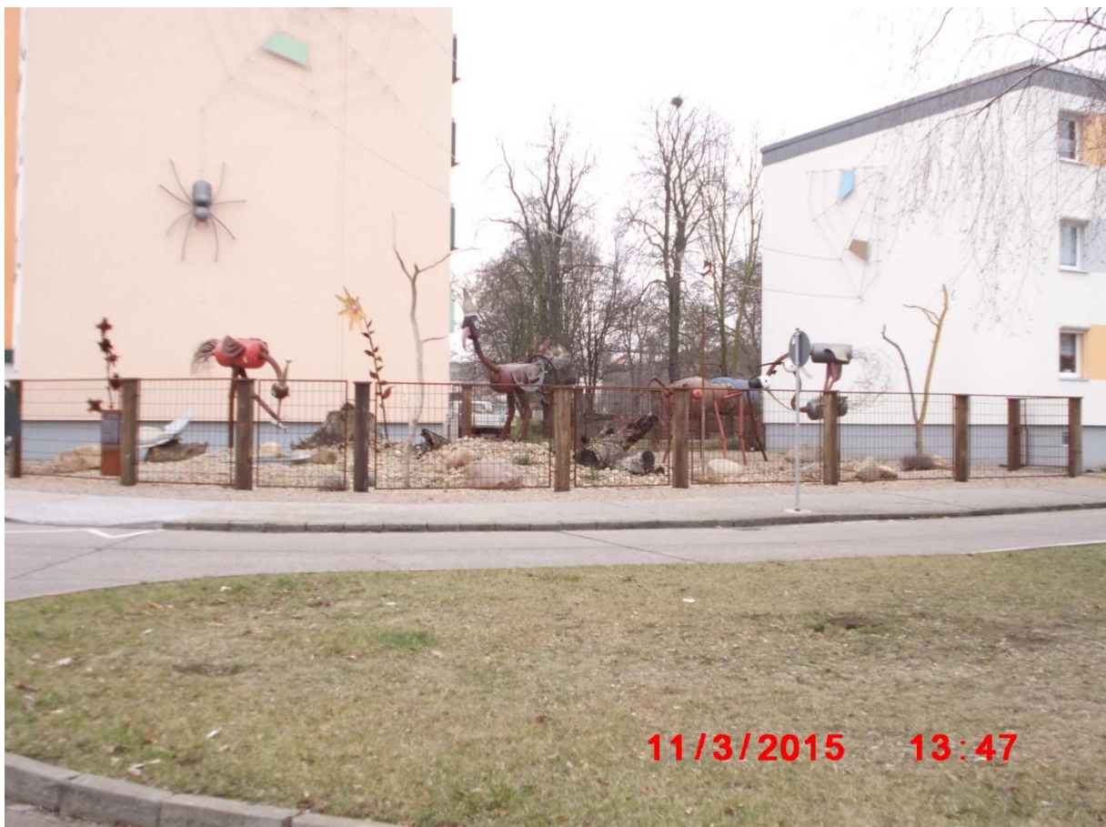
Wohngebäude R.-Breitscheid-Straße 3-19 nach dem Rückbau im Jahr 2012 Gestaltung der Rückbaufäche durch das Wohnungsunternehmen
