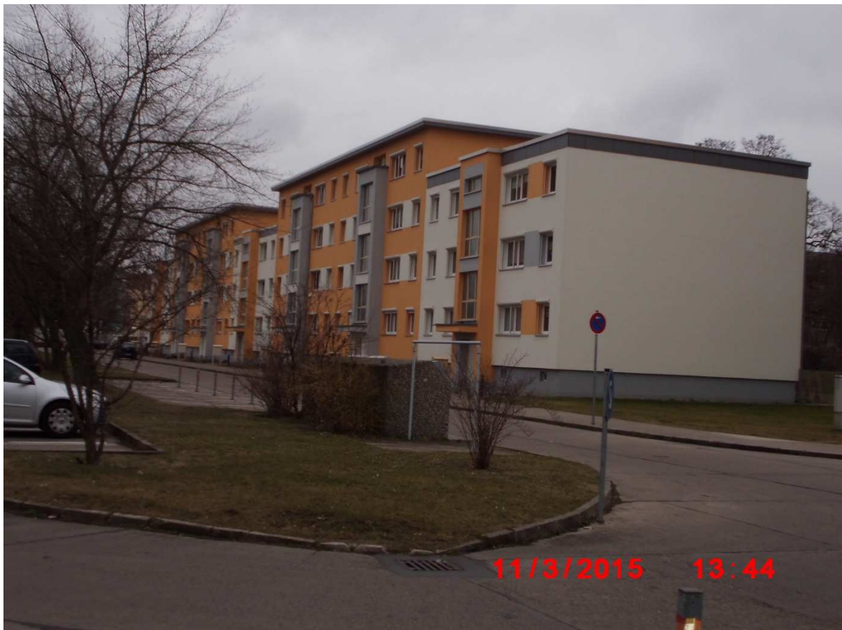
Wohngebäude R.-Breitscheid-Straße 3-19 nach dem Rückbau im Jahr 2012
