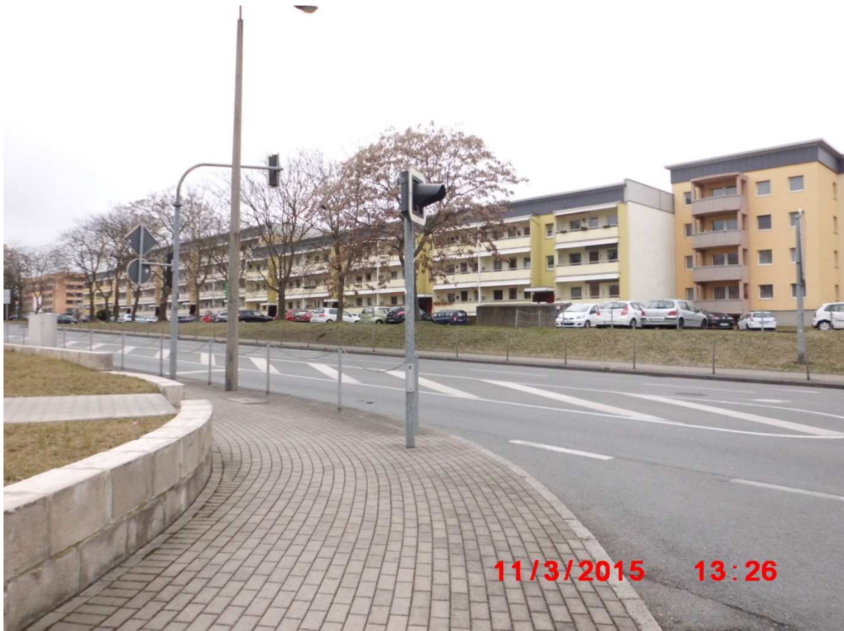
Wohngebäude Berliner Straße 1-11, 13-19 + 21-25 nach dem Etagenrückbau in den Jahren 2005, 2006 und 2007
