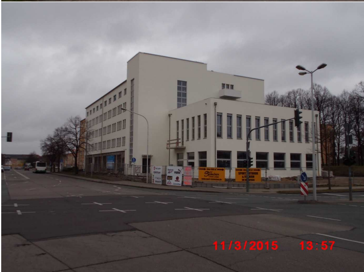
Volkshaus an der Rudolf-Breitscheid-Straße - Sanierung durch privaten Eigentümer
