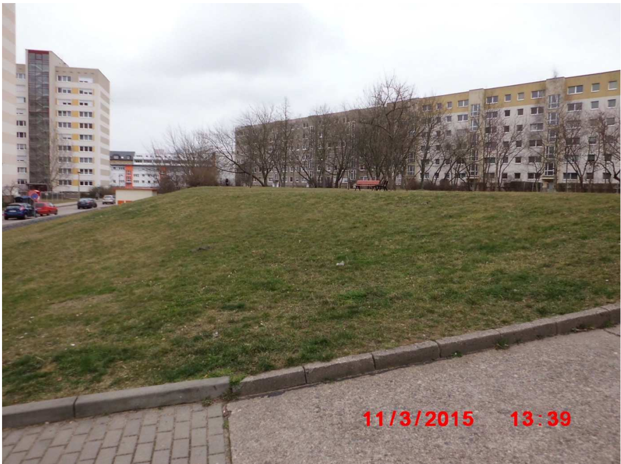
Karl-Marx-Ring 66 vor und nach dem Rückbau der ehem. Kindereinrichtung im Jahr 2007
