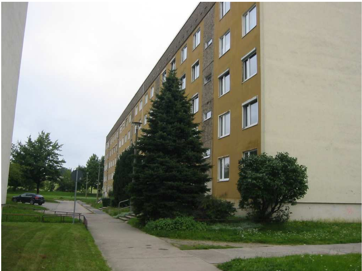
Wohngebäude Hans-Beimler-Straße 35-43 und 36-44 vor dem Rückbau in den Jahren 2008 + 2010
