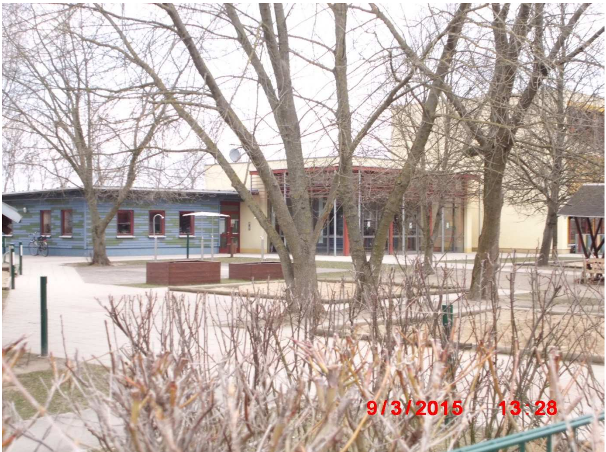
KiTa Mischka, Alleestr. 88, vor + nach dem Erweiterungsbau zum Integrativen Treff im Jahr 2007-09
