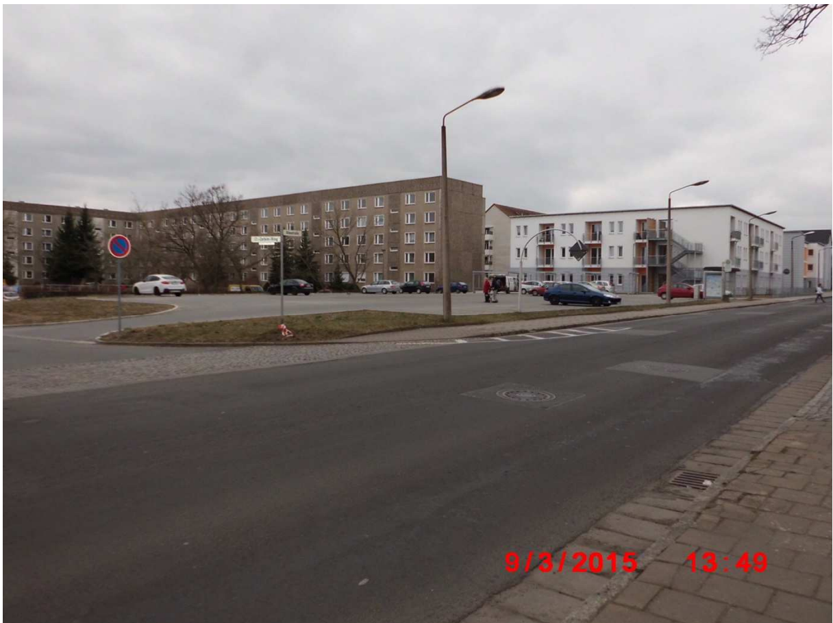
Wohngebäude Alleestraße 69-75 vor und nach dem Rückbau im Jahr 2011
