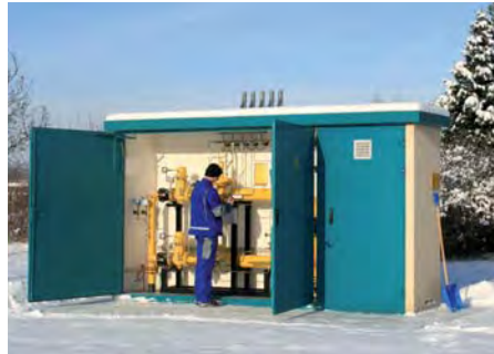
Gasdruckregelanlagen reduzieren den Gasdruck auf den Wert, den das nachgeschaltete Netz bzw. die nachgeschalteten Anlagen wie zum Beispiel Heizung und Gasherd benötigen.
