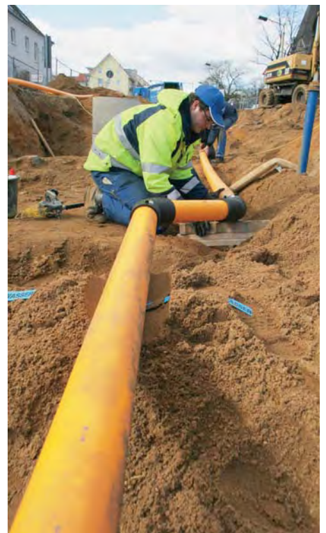
Verlegung einer Gasleitung
