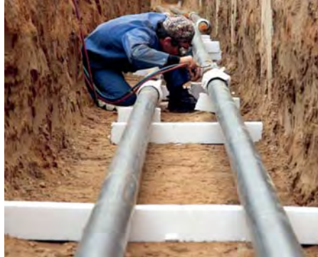
Schweißarbeiten an einer Fernwärmeleitung
