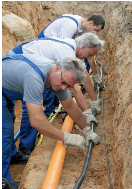
Verlegung eines Elektrokabels
