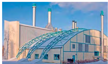
Sechs Erzeugungsanlagen versorgen auch bei Eiseskälte 40 Prozent der Riesaer Wohnungen zuverlässig mit Fernwärme. Im Bild: HKW Merzdorf
