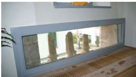
Auch die Reste des 5-Bogen-Fensters blieben sichtbar erhalten.
