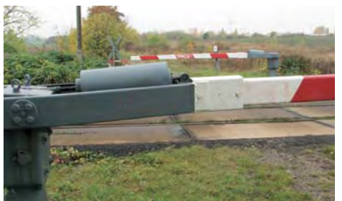
Hat bald ausgedient: der Bahnübergang zwischen den Stadtteilen Weida und Pausitz.
